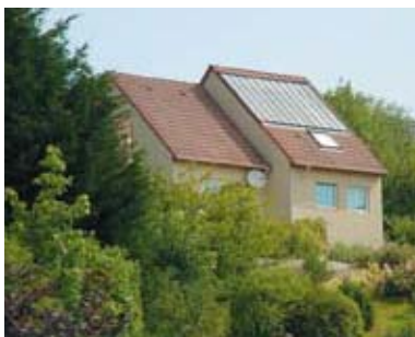
Maison individuelle à Besançon (Doubs) : 120 m 2 habitables, occupée par quatre personnes et 18 m 2 de capteurs en toiture (chauffage d'appoint intégré par chaudière électrique).
