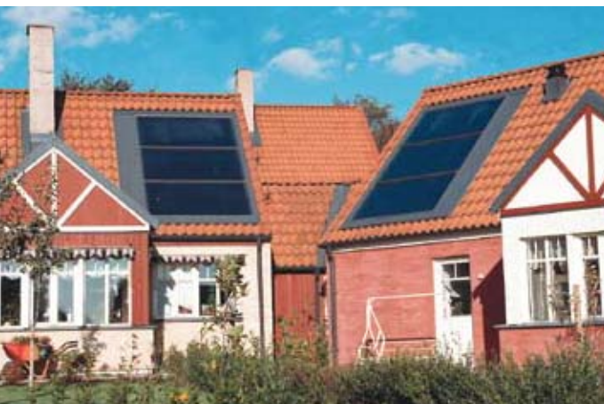
Maison individuelle en Suède : 18 m 2 de capteurs, 1 500 litres de stockage, appoint par chaudière à granulés bois.
