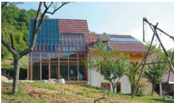
Maison individuelle à Besançon (Doubs) : 140 m 2 habitables, occupée par cinq personnes ; 16 m 2 de capteurs en toiture (avec un chauffage d'appoint séparé au bois).
