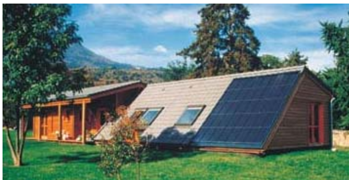
Maison individuelle à Chapareillan (Isère) : occupée par quatre personnes, 16 m 2 de capteurs en toiture.
